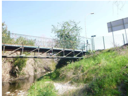
Figure 3 : photographie de la passerelle existante
