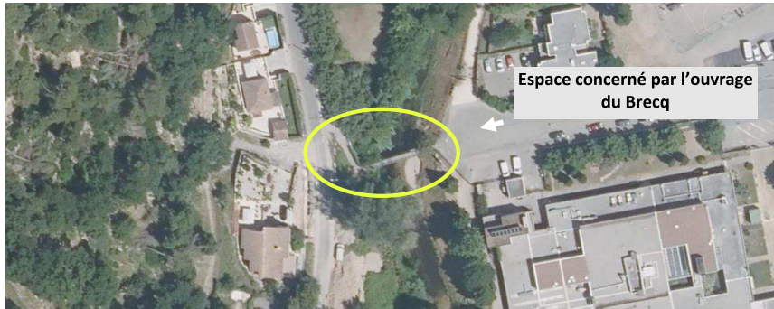
Figure 9 Zoom sur l'ouvrage de franchissement existant
